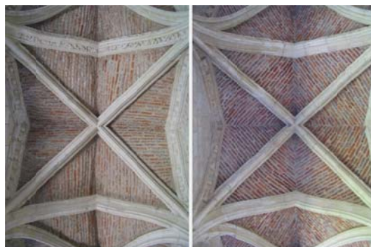
Figura 11. Bóvedas con plementería de ladrillo, antes de la restauración. Fuente: Eduardo Barceló.
