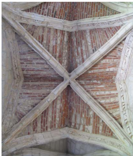
Figura 12. Bóveda con plementería de ladrillo y canto rodado, antes de la restauración. Fuente: Eduardo Barceló.
