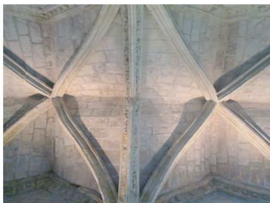
Figura 13. Bóvedas con plementería de piedra.
