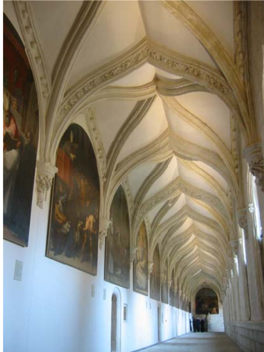
Figura 1. Claustro del monasterio de Santa María de El Paular. Bóvedas conopiales.
