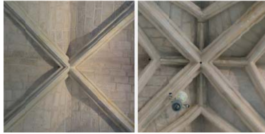
Figura 10. Detalle de encuentro de los nervios en la clave.
