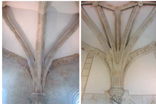
Figura 15. Detalle de las jarjas. Bóveda tipo y de entrada.
