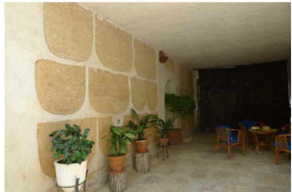
Fig. 2.- Tapias con brenca, característica del cerramiento. Fuente: M. Díaz.
