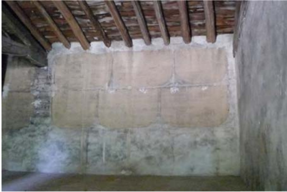
Fig. 3.- Cerramiento interior planta alta. Fuente: M. Díaz.
