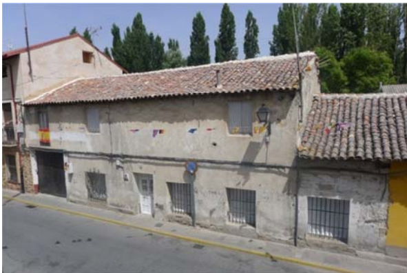
Fig. 1.- Fachada a calle Mayor Baja. Fuente: M. Díaz.
